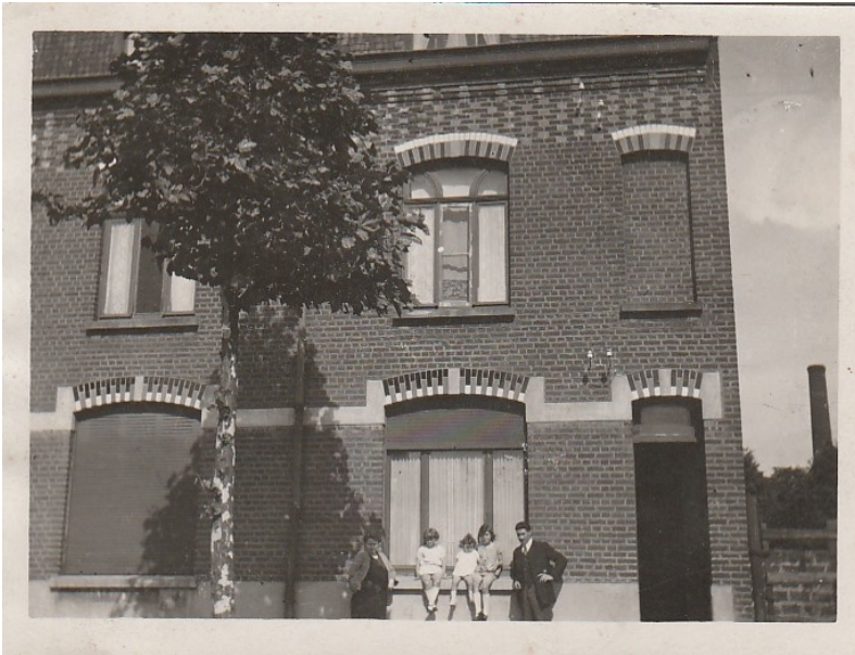
1930_45Bd_Republique_L00S maison côté rue
